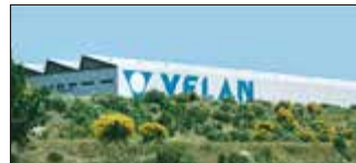
Lisbon, Portugal Velan Válvulas Industriais, Lda.
